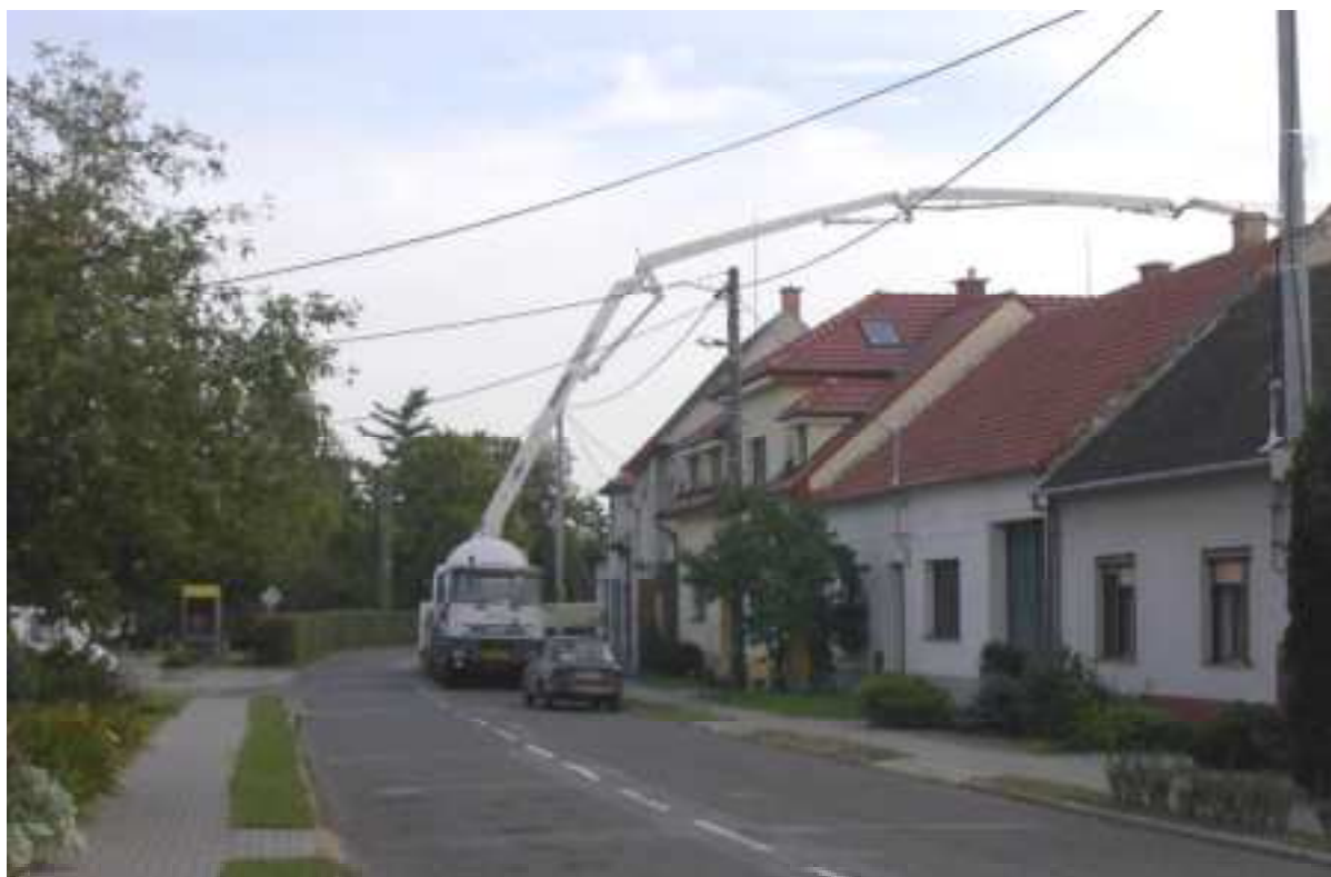
Betonářské práce na přístavbě orlovný.
