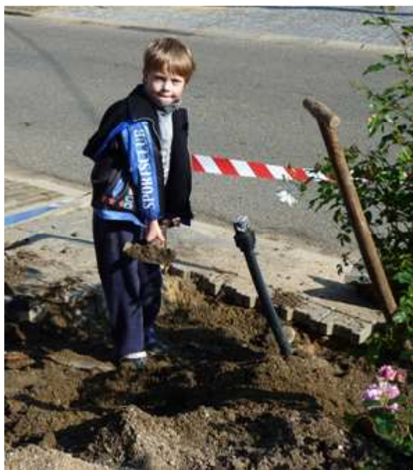
Občané dokončují napojení na kanalizaci. Foto: Marie Jurečková
