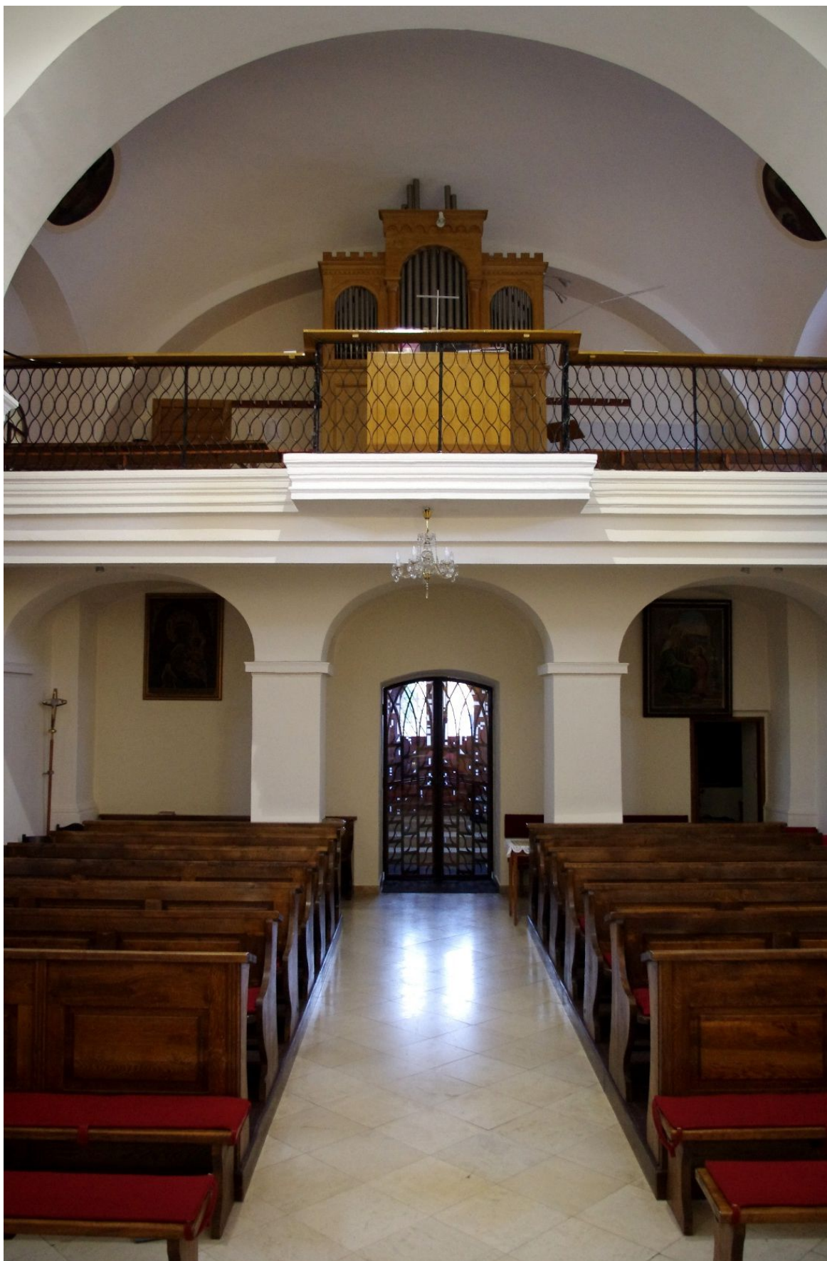
Pohled do lodi chrámu s novými lavicemi, novou dlažbou, odstraněnými kovovými podpěrami kůru a vpravo vzadu s dveřmi do nově zbudované zpovědní místnosti. Nové dubové lavice dodalo výrobní družstvo Stavba Brno v roce 1981.
