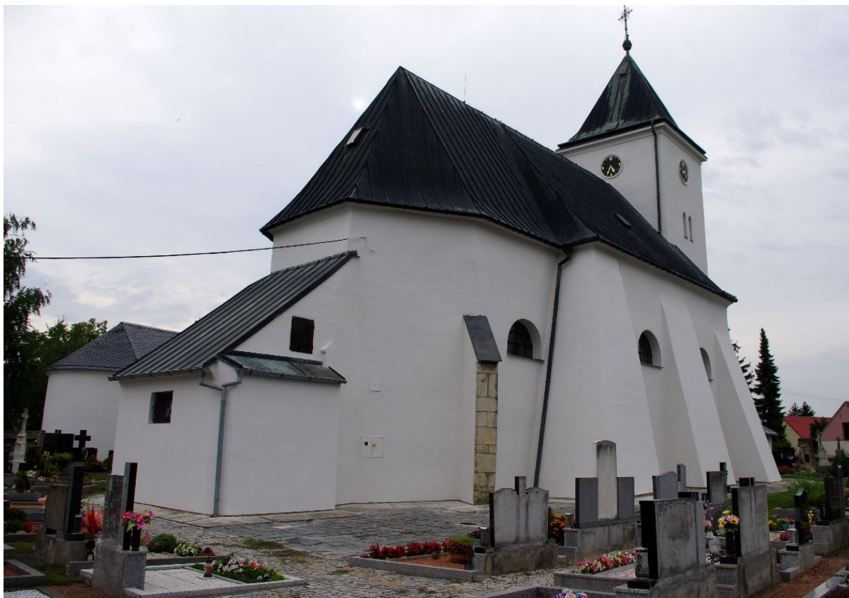
Pohled na opravenou fasádu v roce 2019 – severní strana
