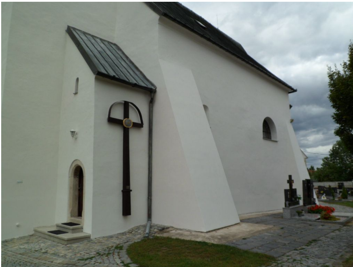
Pohled na opravenou fasádu v roce 2019 – jižní strana
