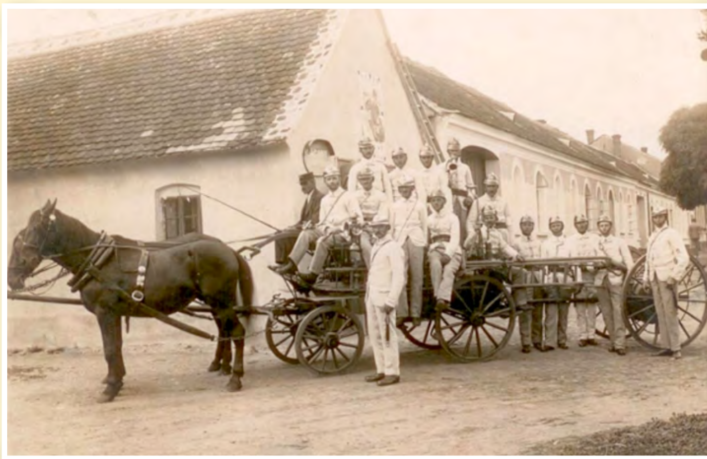
Členové hasičského sboru v roce 1922 s koňmi taženou ruční stříkačkou před hasičským skladištěm, které bylo v roce 1932 zrekonstruováno na hasičskou zbrojnici
