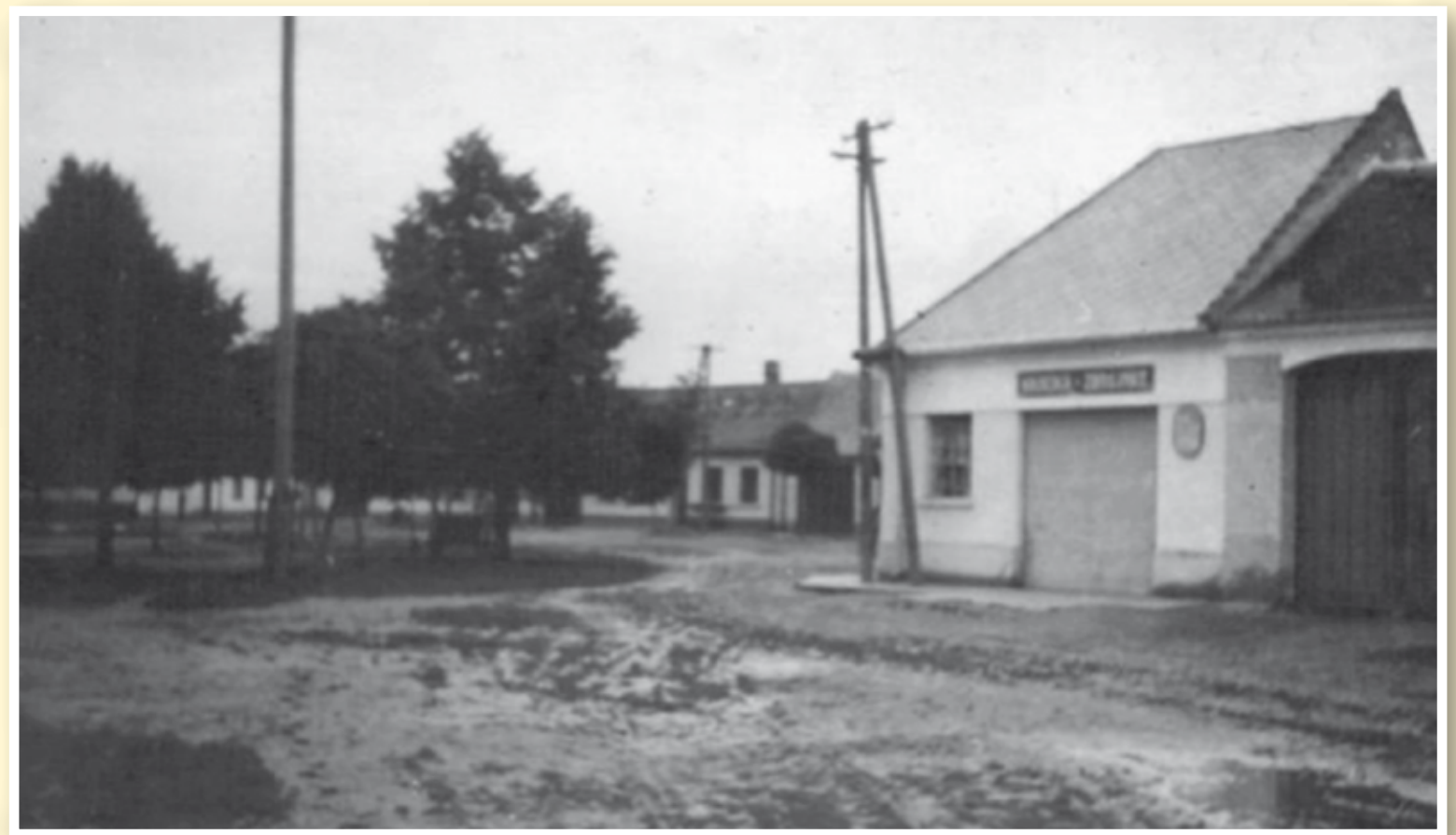
Haltýř a hasičská zbrojnice v roce 1937
